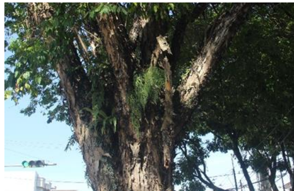
Gambar 11. Kerusakan Batang Patah pada Pohon Tengguli ( Cassia fistula ) di Jalan Ujung Gurun
