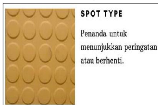
Gambar 11. Spot Type Pada Guiding Block Sumber: RPLP, 2020
